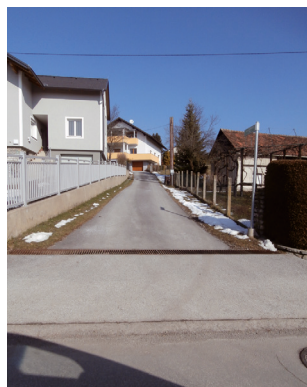
Asphaltierung Kohlhauser/ Wimmer
