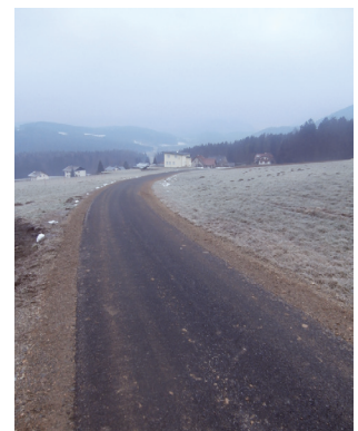
Asphaltierung Fleckweg (öffentlicher Anteil)
